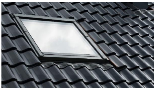
Impressie dakraam verwerkt in pannendak (1140 x 1180 mm)
